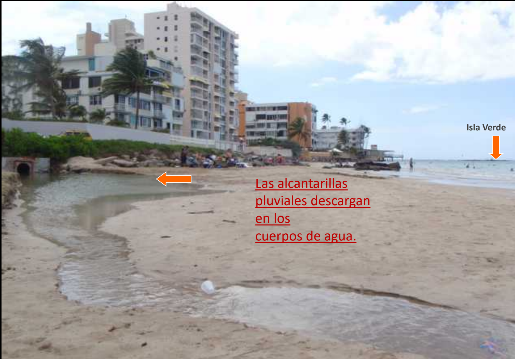
2- Descargas de "aguas pluviales".
